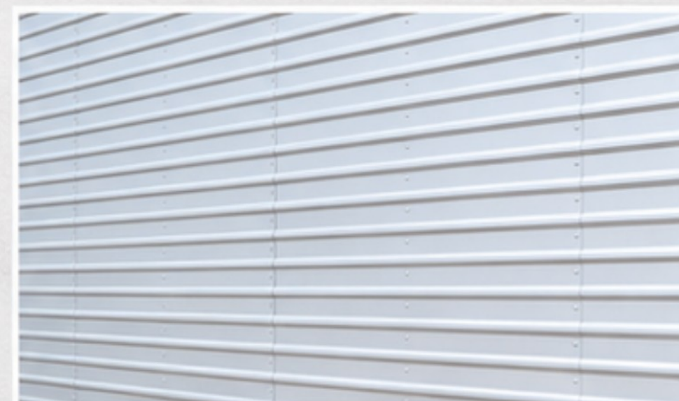
Revestimento externo em chapas frisadas de alumínio, anodizado natural, para maior durabilidade e proteção contra corrosão.
